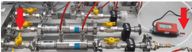
Abbildung 13 LFE Eingang geschlossen, DUT Ausgang geschlossen
